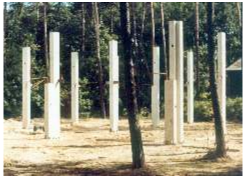
Die aufgestellten Stützen
