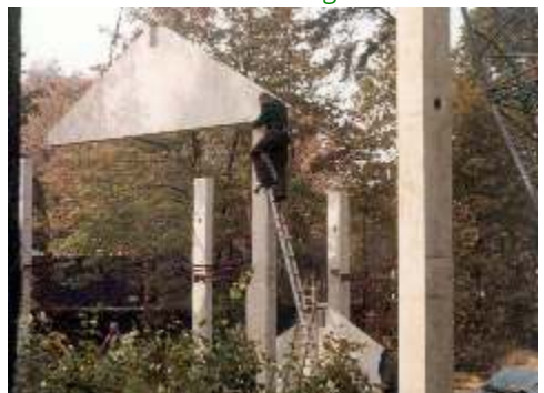
Montage der Dachkonstruktion
