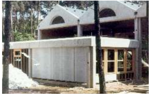
Montage der Außenwände
