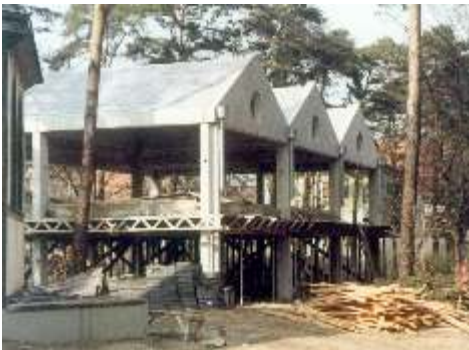
Einbau der Decken (hier in den Pfarrhäusern)
